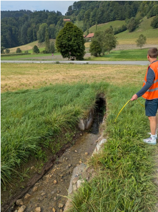
Abbildung 25: Einlauf zum Durchlass Kantonsstrasse des Mattenbachs, gut ersichtlich ist die Stauwand zur Erhöhung der Abflusskapazität durch Druckabfluss, Blick in Fliessrichtung (Aufnahme: 20.08.2025).
